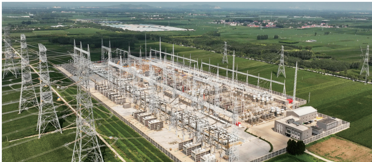
雄安1000千伏特高压变电站扩容工程建设工地
