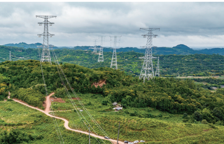
川渝1000千伏特高压交流工程线路工程施工现场
