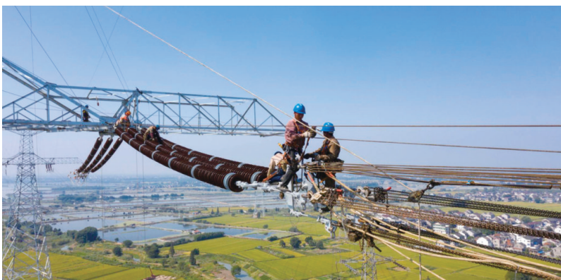
工人对白鹤滩—江苏±800千伏直流输电工程线路进行附件安装
