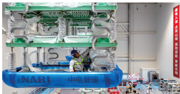
“疆电入渝”特高压渝北±800千伏换流站工程施工现场
